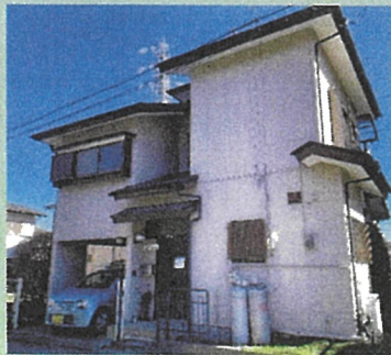
詰め所(事務所)の外観
